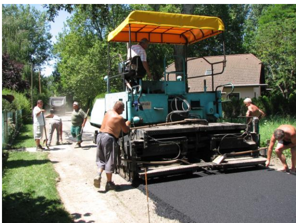
Aszfalt terítése finisherrel a „Pomászbán”
